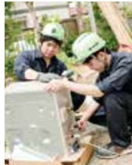
取り扱う設備は重量もあるため、ほとんどの作業は2人1組で行う。施工現場は新人教育の場でもある
