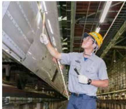
ボルトのゆるみがないか一つ一つハンマーで打検する
