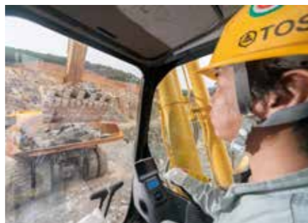
油圧ショベルを使って、同僚が運転するダンプに原石を積み込む作業を行う
