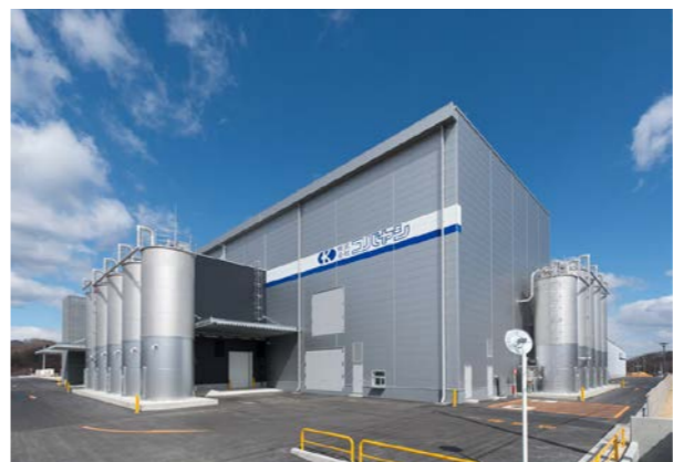
2016年4月に竣工した東北工場。同社は東日本大震災復興支援の一環と位置付け、東北工場の整備を2013年から進めてきた
