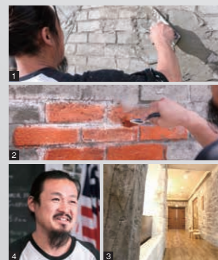
1.レンガ積みの造形の上にさらにモルタルを重ね、修復の痕跡を表現する 2.レンガ風に仕上げるため、ブラシを使って丁寧に彩色する。古いレンガ積みによく見られるエフロレッセンス（白華現象）も描き足すことで、リアル感がさらに増す 3.モルタル造形を駆使して、イギリスの田舎にあるようなレトロな雰囲気演出する 4.「塗りの命は均一さです」と語る櫻本さん。エイジングペイントにおいても、自然な経年変化を表現するために、バランス感覚が重要だと話す
