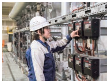
炉に取り付けられている計器を見て異常が検出されていないかチェックする
