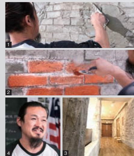
1.レンガ積みの造形の上にさらにモルタルを重ね、修復の痕跡を表現する 2.レンガ風に仕上げるため、ブラシを使って丁寧に彩色する。古いレンガ積みによく見られるエフロレッセンス（白華現象）も描き足すことで、リアル感がさらに増す 3.モルタル造形を駆使して、イギリスの田舎にあるようなレトロな雰囲気演出する 4.「塗りの命は均一さです」と語る櫻本さん。エイジングペイントにおいても、自然な経年変化を表現するために、バランス感覚が重要だと話す
