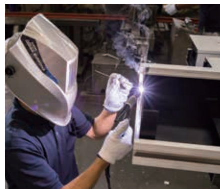
組み立てた材料を溶接してつなぎ合わせる
