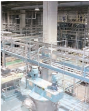
石巻工場内で稼働する量産設備。TEMPO課題クリアを目標に、勝負の毎日が続いています」と話す
