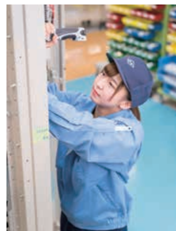
ドライバーを使ってケーブルをつなぐ。配線を間違えないよう集中
