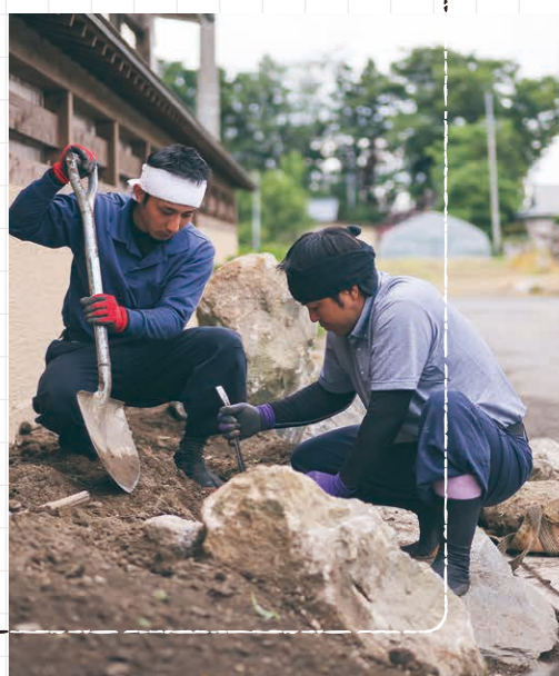
保水力の高い鳴子石を使って土留めの石積みを行う松島部長(右)と見上さん
